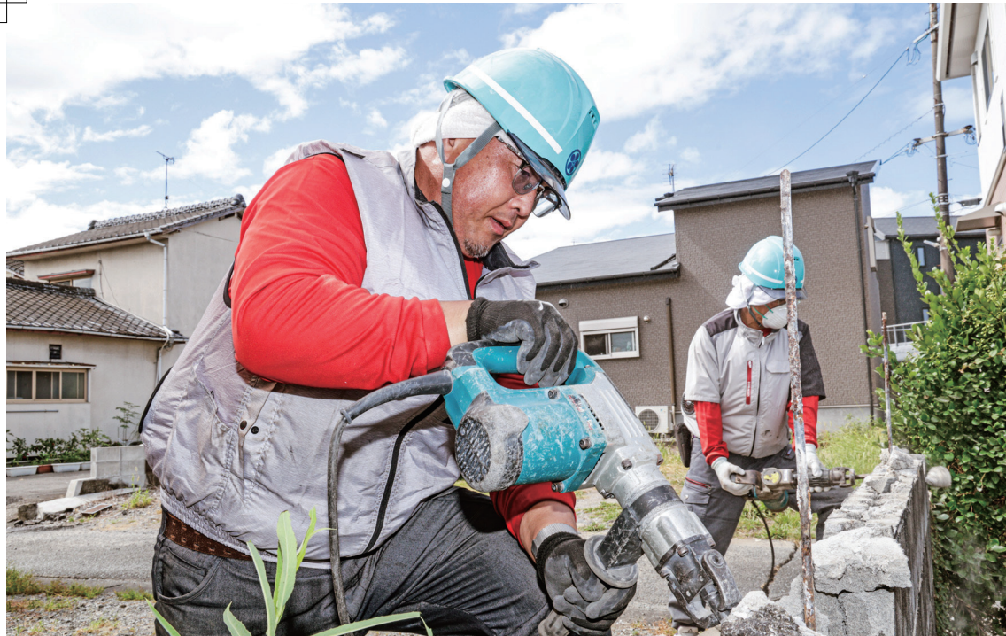
被災した家屋のブロック塀を解体した（8月20日、熊本県八代市で）
