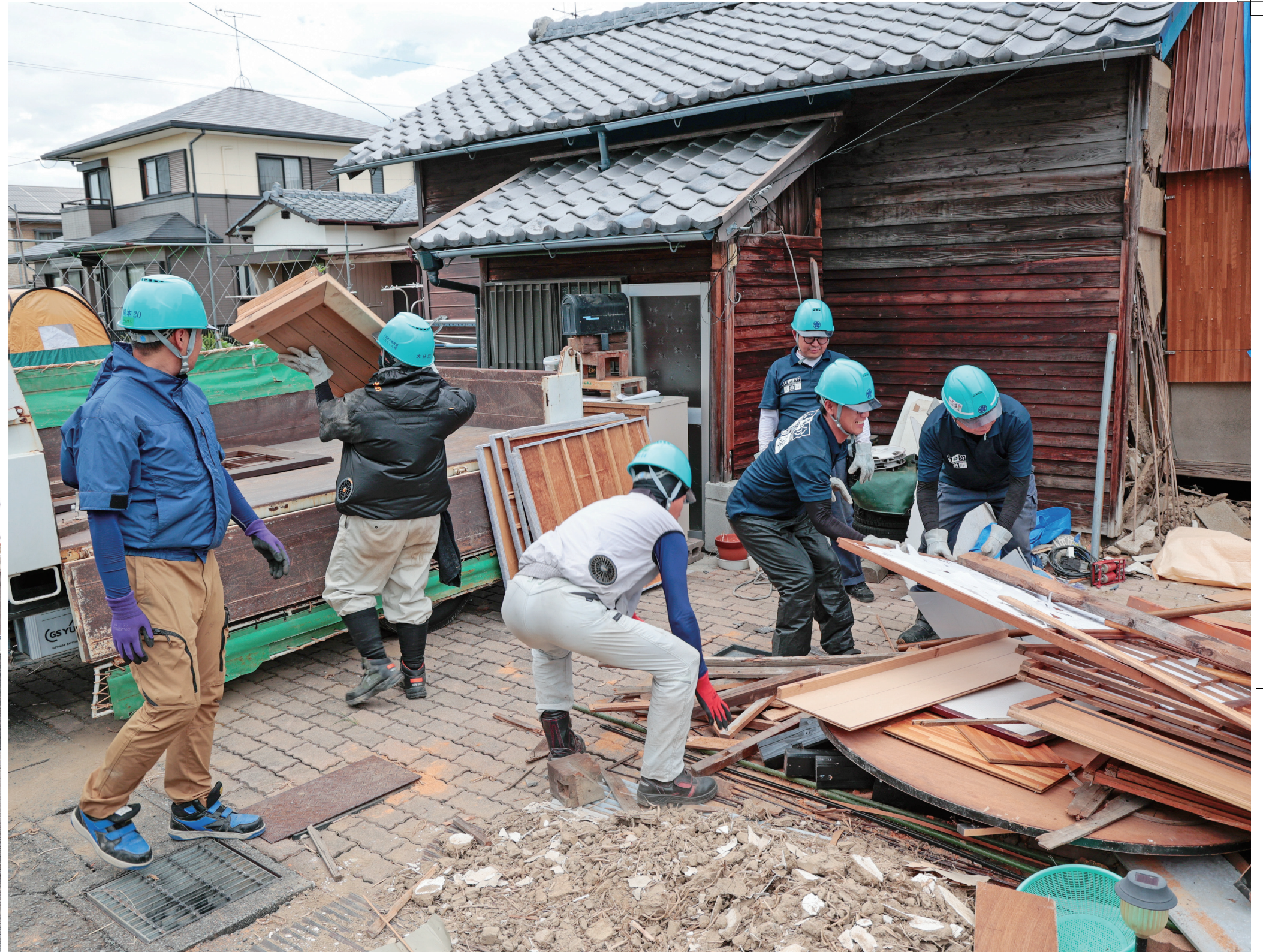
被災家屋から災害廃棄物などを搬出、運搬した（8月7日、同）
